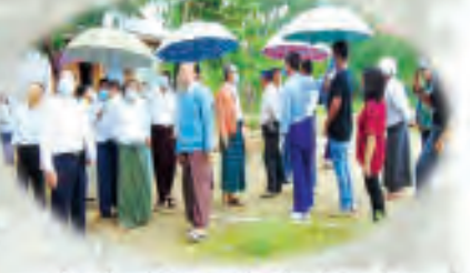
ဥဗ္ဗိန္ဒရယ်၊ ကင်းပုံတော့ရွာ ဟိုတယ်တည်ဆောက်ရေး စီမံကိန်းအခြေအနေစစ်ဆေးနေပုံ
