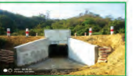
သက်ကိုင်ညာ-ပဒေါင်းတောင်ကျော်လမ်း Box Culvert တည်ဆောက်ခြင်းလုပ်ငန်းဆောင်ရွက်နေပုံ
