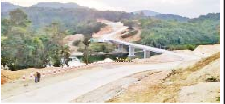
၂၀၁၉-၂၀၂၀ ဘဏ္ဍာနှစ် မချမ်းဘော-ဖရူခ-ရပ်ဘော-နောင်မွန်လမ်းပေါ်ရှိ တံတားအမှတ်(၁/၈) ထီခံတံတား၏ ချဉ်းကပ်လမ်းတာပေါင်ပေါ် ကွန်ကရစ်လမ်းခင်းခြင်းလုပ်ငန်း ဆောင်ရွက်ပြီးစီးမှုကို တွေ့ရစဉ်။
