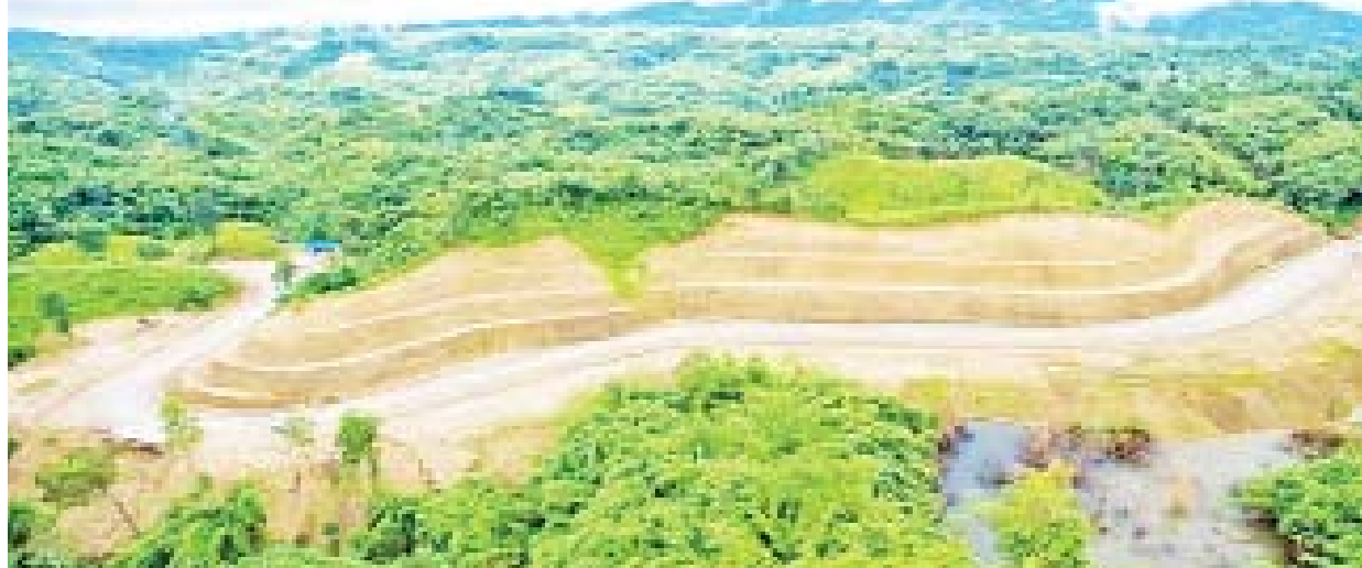
မြစ်ကြီးနား-ဆွမ်ပရာဘွမ်-ပူတာအိုလမ်း km(83.39-85.5)အတွင်း (5.49m) အကျယ် ကွန်ကရစ်ခင်းခြင်းလုပ်ငန်းဆောင်ရွက်စဉ်။
