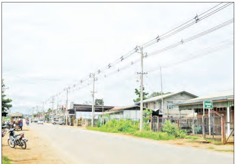
လှိုင်ကော်မြို့တွင် အစားထိုးအဆင့်မြှင့် တည်ဆောက်ပြီးစီးခဲ့သည့် ၈၀-၅၀၀ ခွဲရံမှ မိုင်းလုံးခွဲကြား ၃၃ ကေစီ SAC လိုင်း (၂.၂)မိုင်ကို တွေ့ရစဉ်။
