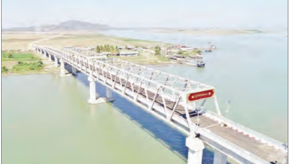
ရခိုင်ပြည်နယ် မြေပုံ-မင်းပြား လမ်းပေါ်ရှိ တည်ဆောက်ပြီး ကြပ်စင်တံတားကို တွေ့ရစဉ်။
