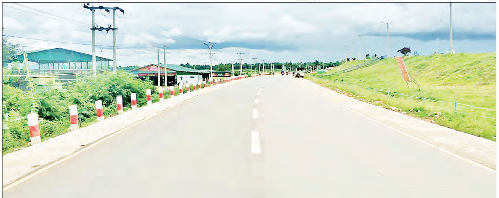
တောင်ငူ - လိပ်သို - ယာဒို - လွိုင်ကော် - ဟိုပုံးလမ်း ဒီးမော့ဆိုမြို့တွင်း ကတ္တရာကွန်ကရစ်ခင်းခြင်းလုပ်ငန်း ဆောင်ရွက်ပြီးစီးမှုကို တွေ့ရစဉ်။
