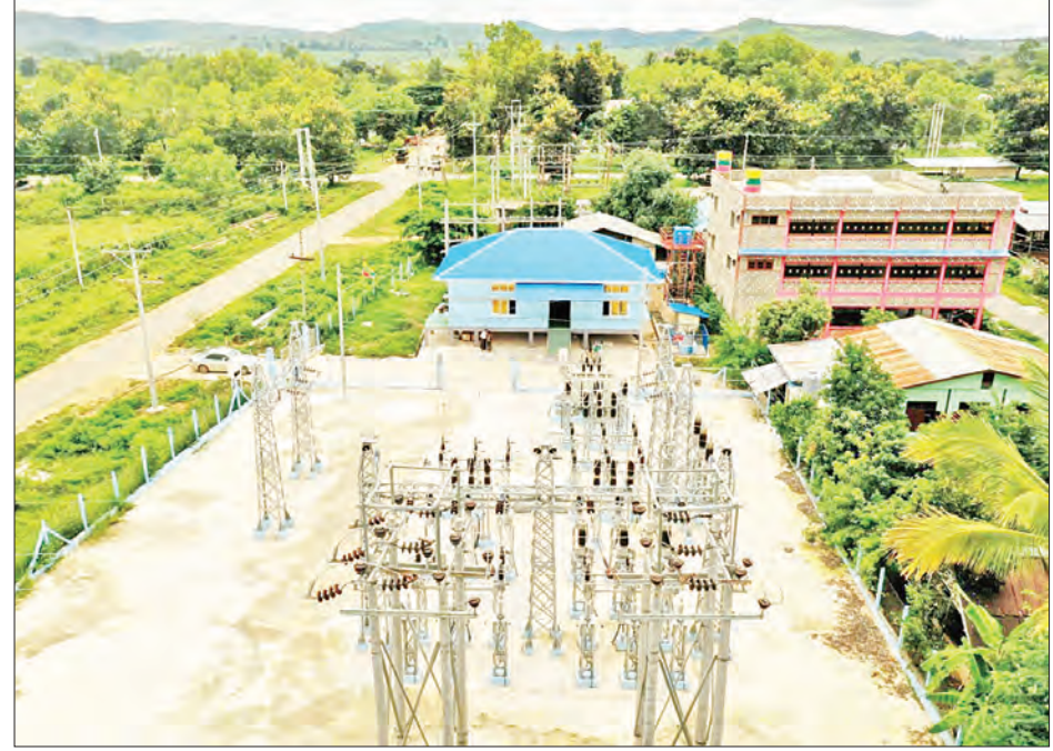
လျှင်ကော်မြို့ ၃၃/၁၁ ကေဗီ ၅ အမိစီအမှ ၁၀ အမိစီအသို့ အင်အားတိုးမြှင့်တည်ဆောက်ပြီးစီးသည့် ၈က-၅၀၀ ဓာတ်အားခွဲရုံကို တွေ့ရစဉ်။
