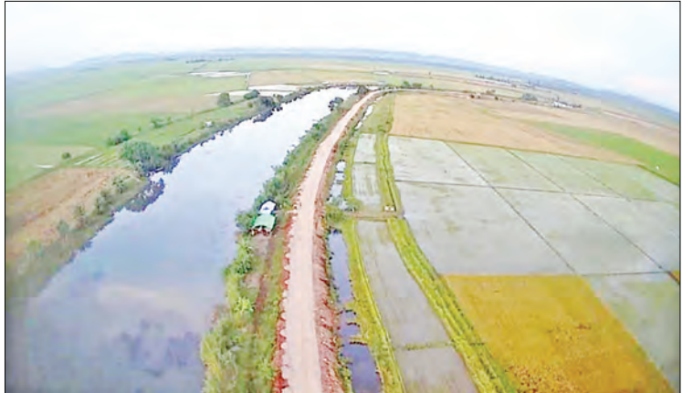
ဒီးမော့ဆိုမြို့နယ် ဘုရားဖြူ - ပလဖလမ်း လမ်းမြေသားတာပေါင်ချဲ့ခြင်းနှင့် ကျောက်ချောလမ်း (၄/၂.၂)မိုင် ခင်းခြင်းလုပ်ငန်း ဆောင်ရွက်ပြီးစီးမှုကို တွေ့ရစဉ်။
