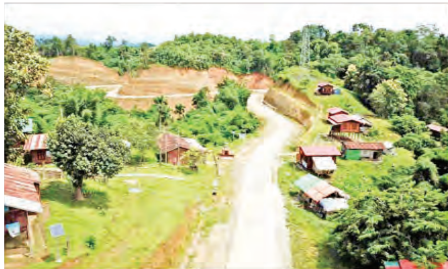
၂၀၁၉-၂၀၂၀ ဘဏ္ဍာနှစ် မြစ်ကြီးနား-ဆွမ်ပရာဘွမ်-ပူတာအိုလမ်း ကီလိုမီတာ (၉၄-၉၅)အတွင်း ကွန်ကရစ်ခင်းခြင်း လုပ်ငန်းဆောင်ရွက်ထားရှိမှုကို တွေ့ရစဉ်။
