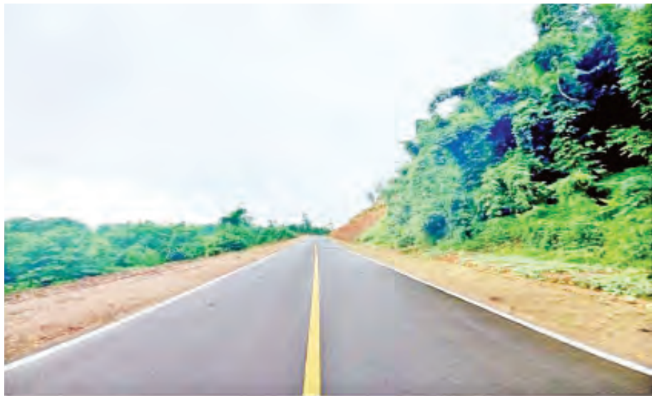
၂၀၁၉-၂၀၂၀ ဘဏ္ဍာနှစ် မန္တလေး-လားရှိုး-ဗန်းမော်- မြစ်ကြီးနားလမ်းကီလိုမီတာ (၇၁၄.၄၂-၇၁၉.၉၂)အတွင်း ၇ ဒသမ ၃၂ မီတာ အကျယ်ကတ္တရာကွန်ကရစ် (AC)လမ်းခင်းခြင်းလုပ်ငန်း ဆောင်ရွက်နေမှုကို တွေ့ရစဉ်။
