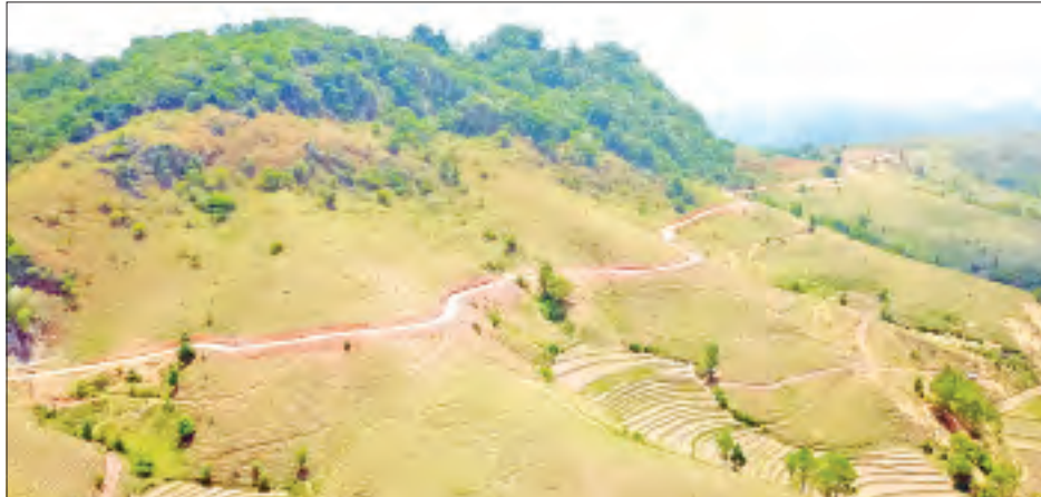
ရာနှုန်းပြည့်ဆောင်ရွက်ပြီးစီးပြီးဖြစ်ကြောင်း သိရသည်။ ယင်းကျေးရွာချင်းဆက်လမ်းနှင့် Box Culvert လုပ်ငန်းများ ဆောင်ရွက်ပေးခြင်းကြောင့် နယ်စပ်ဒေသရှိ ကျေးလက်နေပြည်သူများ ရာသီမရွေးသွားလာနိုင်ပြီး လမ်းတစ်လျှောက်ရှိ ကျေးရွာများအနေဖြင့် ကယား
