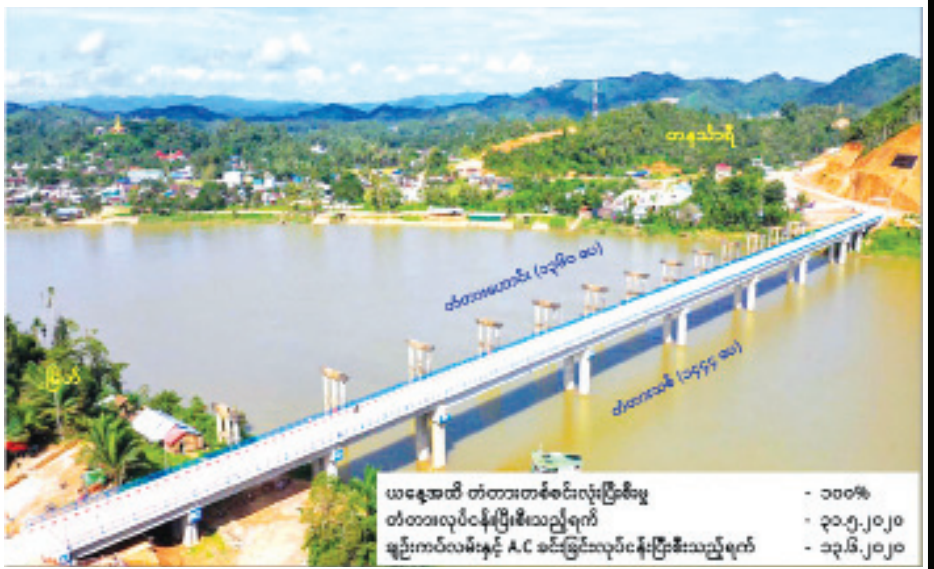
တည်ဆောက်ပြီး တနင်္သာရီတံတားကို မြင်တွေ့ရစဉ်။
