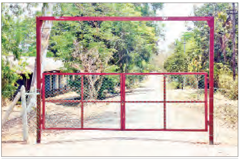
ဗဟိုဝန်ထမ်းတက္ကသိုလ်(အောက်မြန်မာပြည်) ကိုဗစ်-၁၉ ရောဂါကုသရေးဌာနနှင့် ဝန်ထမ်းလှိုင်းများ ရောနှောမှု မရှိစေရန် လုံခြုံရေးတံခါးများ ကာရံထားမှုကို တွေ့ရစဉ်။
