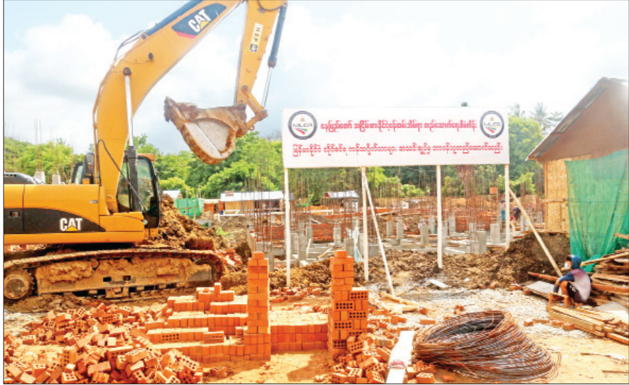
နေပြည်တော်မြို့၊ မဈေးအနီး၌ အငြိမ်းစားနိုင်ငံဝန်ထမ်းအိမ်ရာတည်ဆောက်ရန် စက်ယန္တရားကြီးများဖြင့် မြေညှိနေမှုကိုတွေ့ရစဉ်။
