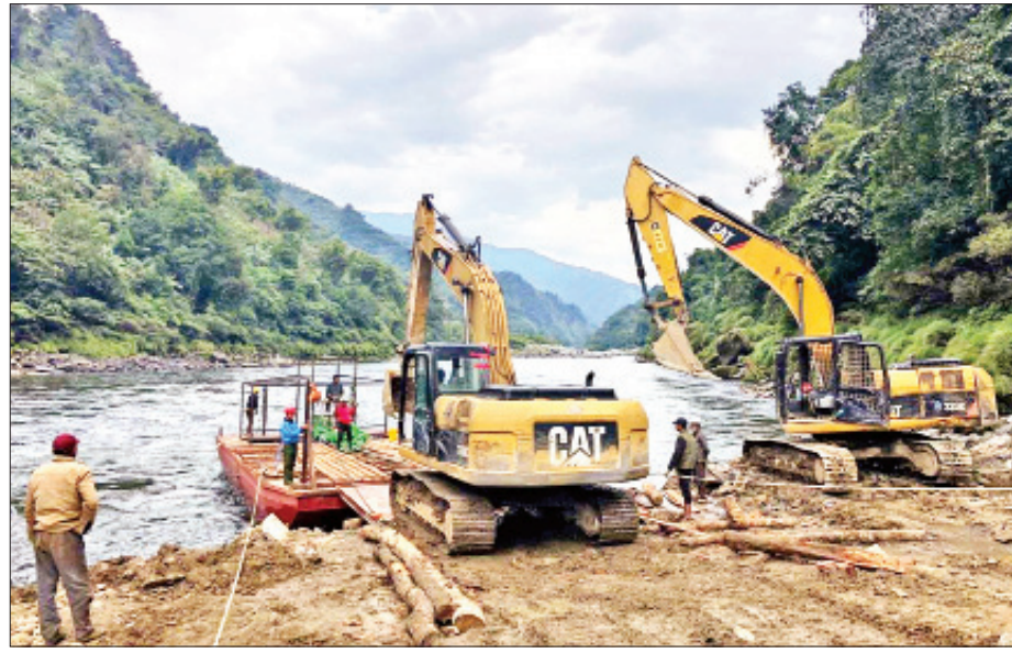
မဂ္ဂေ-ခေါင်လန်ဖူးကားလမ်းဖောက်လုပ်ရန်အတွက် စက်ယန္တရားကြီးများကို ကူးတို့ဖောင်ဖြင့် မေမြစ်အား ဖြတ်ကူးပို့ဆောင်ပေးစဉ်။
