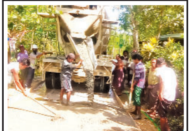
ရန်ကုန်တိုင်းဒေသကြီး သန်လျင်မြို့နယ် ဘုရားကျွန်းကျေးရွာအုပ်စု ကွမ်းမြံ ကျွန်းအနောက်ပိုင်းရပ်ကွက် ပိတောက်လမ်းအား မေ ၂၆ ရက်က ကျေးလက် ဒေသဖွံ့ဖြိုးရေးရန်ပုံငွေနှင့် ဒေသခံပြည်သူများထည့်ဝင်ငွေဖြင့် အရည်ပေ ၁၂၀၊ အကျယ် ၁၀ ပေ၊ ဒု ခြောက်လက်မ ကွန်ကရစ်ခင်းလုပ်ငန်း ဆောင်ရွက်စဉ်။ အောင်ကျော်ဦး
