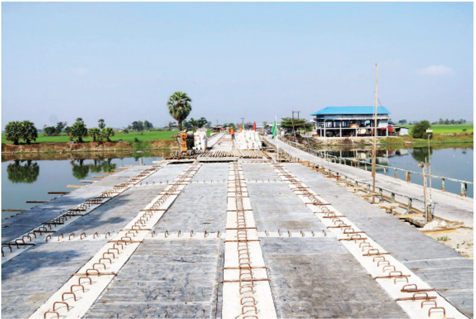
မွန်ပြည်နယ် မေါင်မြို့နယ်ရှိ ကျိုဟော်-ရာမဆိပ်တံတားအား တည်ဆောက်လျက်ရှိသည်ကို တွေ့ရစဉ်။
