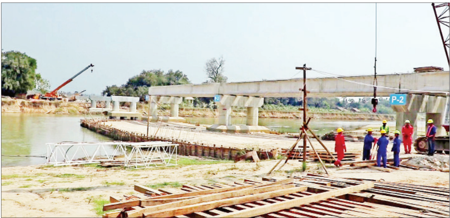
စစ်တောင်းမြစ်ကူးတံတား တည်ဆောက်နေမှုကို တွေ့ရစဉ်။
