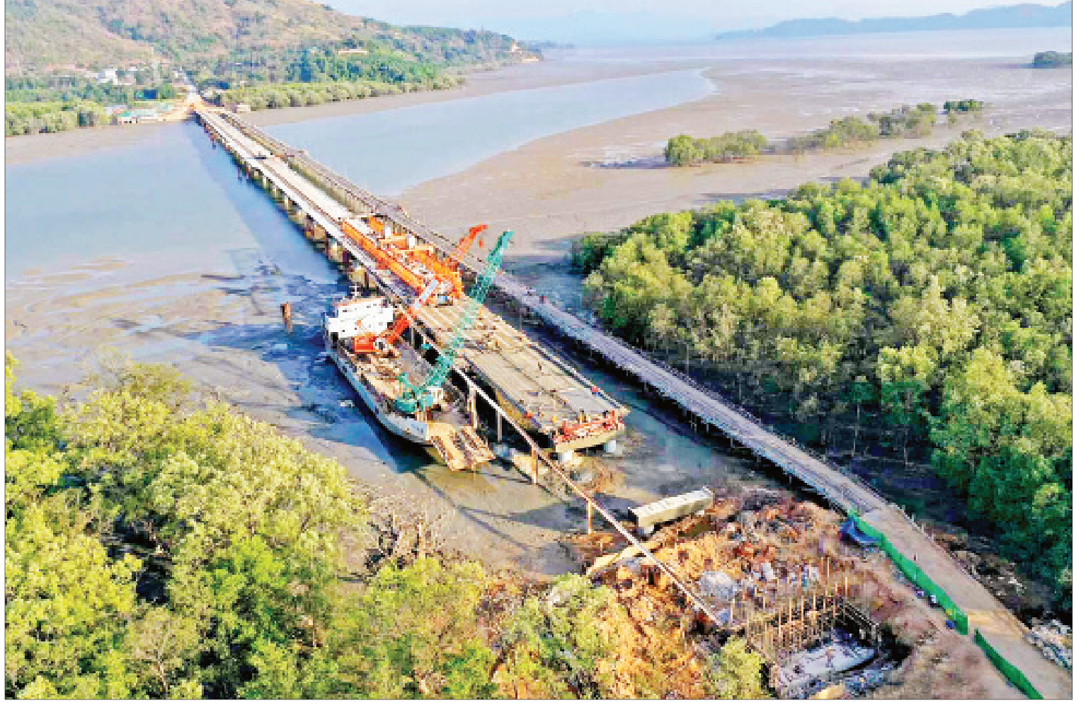
၂၀၁၉-၂၀၂၀ ဘဏ္ဍာနှစ်တွင် တံတားဦးစီးဌာန တည်ဆောက်ရေးအဖွဲ့(၄)မှ တည်ဆောက်လျက်ရှိသော အရှည်ပေ ၂၄၀၀ ရှိသည့် ပုလဲတံတားတံတားကို တွေ့ရစဉ်။
