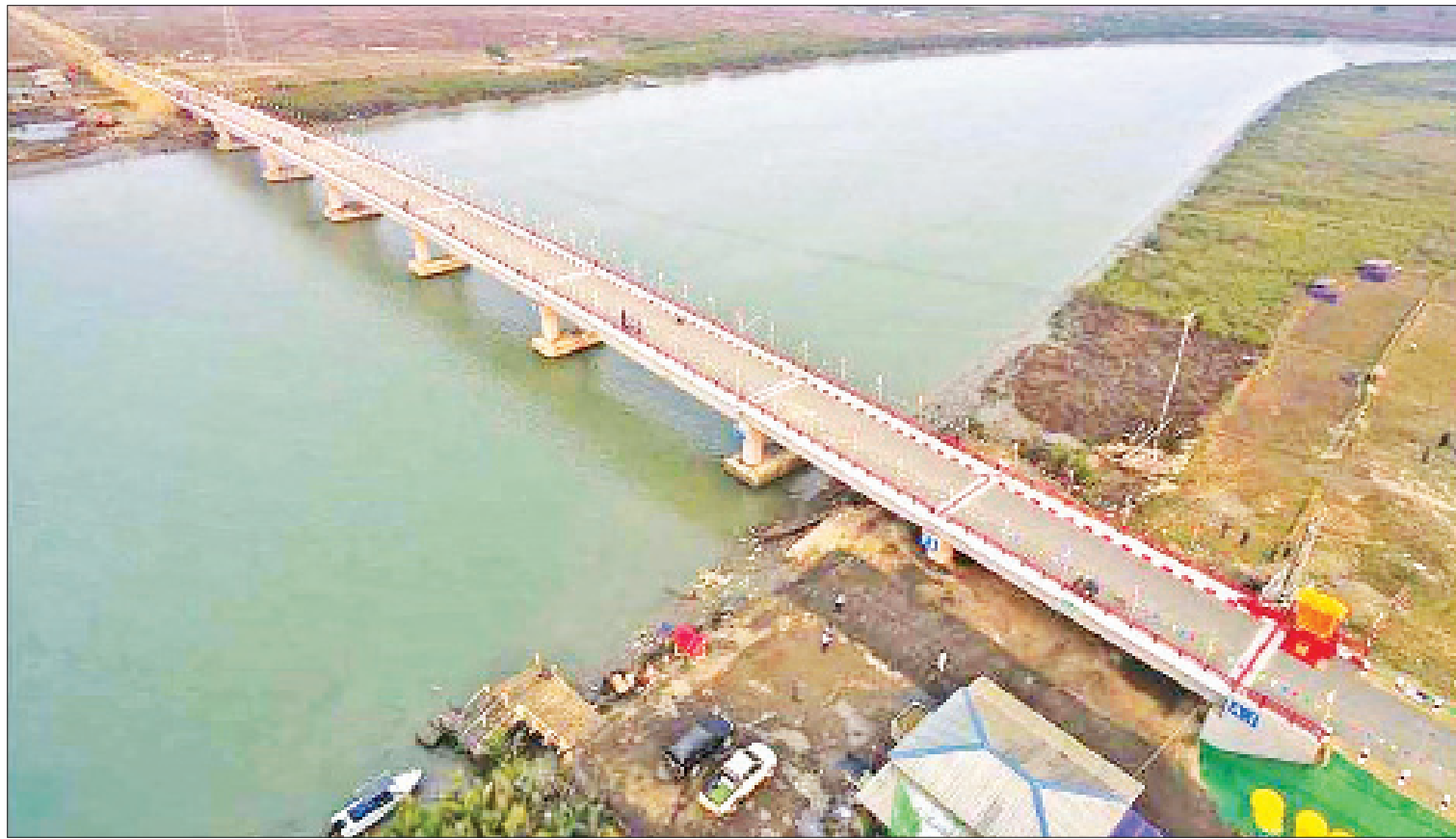
၂၀၁၇-၂၀၁၈ ဘဏ္ဍာနှစ်တွင် ပုဏ္ဏားကျွန်း-ရသေ့တောင် ဆက်သွယ်သော ပေ ၈၈၀ အရှည်ရှိ ရသေ့တောင်ချောင်းတံတား ဆောင်ရွက်ပြီးစီးမှုကို တွေ့ရစဉ်။
