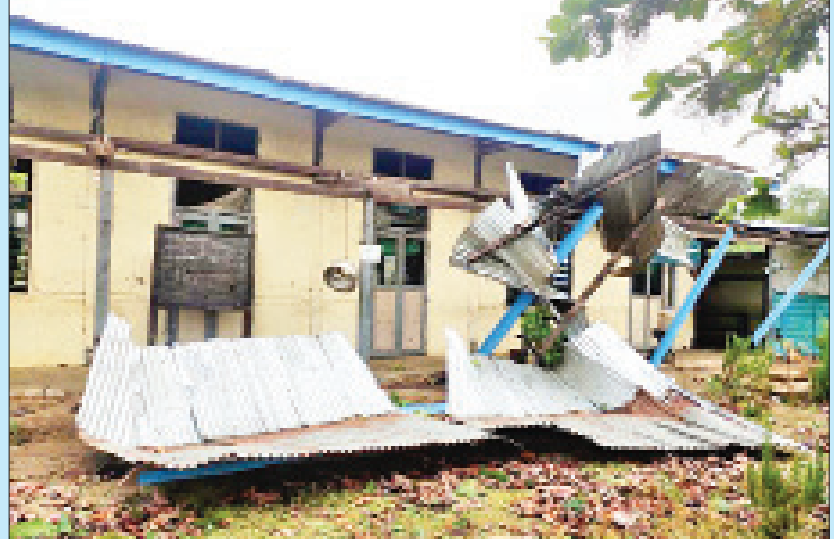
ကျောက်ကြီးမြို့နယ်၌ လေပြင်းတိုက်ခတ်မှုကြောင့် စာသင်ကျောင်းတစ်ကျောင်း အမိုးလန်ပျက်စီး မှုကို တွေ့ရစဉ်။
