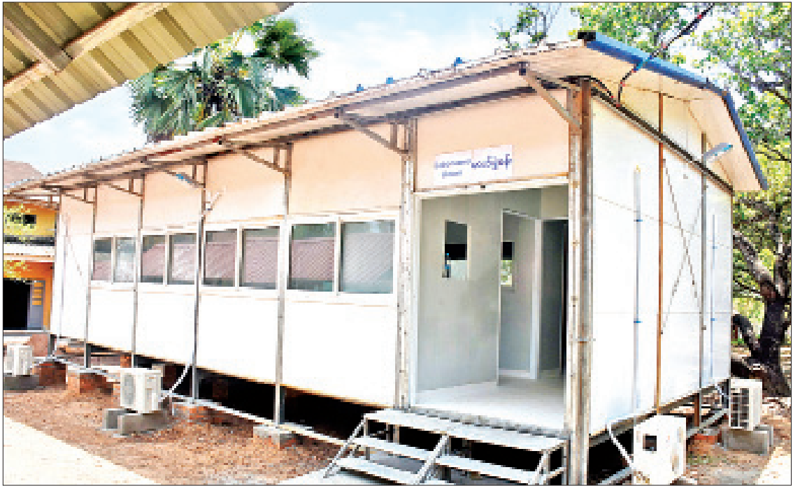
ဗဟိုဝန်ထမ်းတက္ကသိုလ် (အောက်မြန်မာပြည် ) ကိုဗစ် -၁၉ ရောဂါ ကုသရေးဌာနရှိ ဓာတ်ခွဲခန်းအဆောက်အအုံအား တွေ့ရစဉ်။
