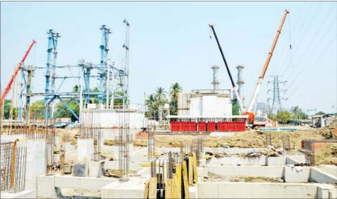
အလုံ ၁၅၁ မဂ္ဂါဝပ်ဓာတ်အားပေးစက်ရုံတည်ဆောက်ရေးစီမံကိန်း
