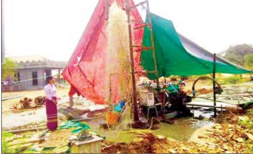
ကျေးရွာတွင် အကျယ် သုံးလက်မ၊ အနက် ပေ ၇၀ ရှိ စက်ရေတွင်းငါးတွင်း တူးဖော်ခြင်း၊ ရေစက်ရုံ ရေစင် တည်ဆောက်ခြင်း၊ ရေပိုက်သွယ်တန်းခြင်း၊ ၄၀၀ ဗို့ဓာတ်အားလိုင်း သွယ်တန်းခြင်းလုပ်ငန်း များနှင့် ဒီးဒုတ်တောင်ကျေးရွာတွင် အကျယ် နှစ် လက်မ၊ အရှည် ပေ ၂၇၀၀ ရှိ အိမ်တိုင်ရာရောက်
