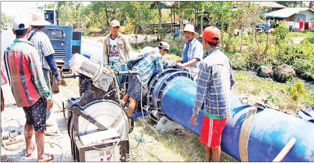
တွံတေးမြို့နယ်၌ ရေသန့်စင်စက်ရုံတည်ဆောက်ရန် ရေပိုက်လိုင်းဆက်သွယ်ခြင်းလုပ်ငန်းများ ဆောင်ရွက်စဉ်။
