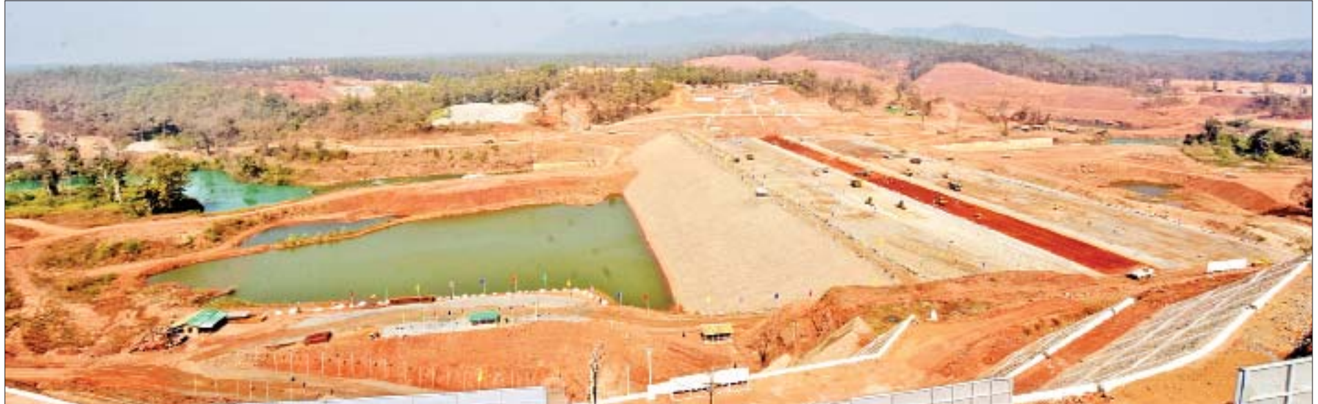
အထက်ကျိုင်းတောင်းရေအားလျှပ်စစ်စီမံကိန်း တည်ဆောက်ရေးလုပ်ငန်းများ ဆောင်ရွက်နေမှုကို တွေ့ရစဉ်။
