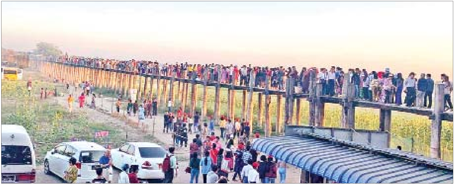
ဒီဇင်ဘာပိတ်ရက်များတွင် ဦးပိန်တံတားသို့ ပြည်တွင်း ပြည်ပခရီးသွားများ စည်ကားများပြားစွာ လာရောက်လည်ပတ်စဉ်။ ဓာတ်ပုံ - အောင်ဖြိုးရှိန်
