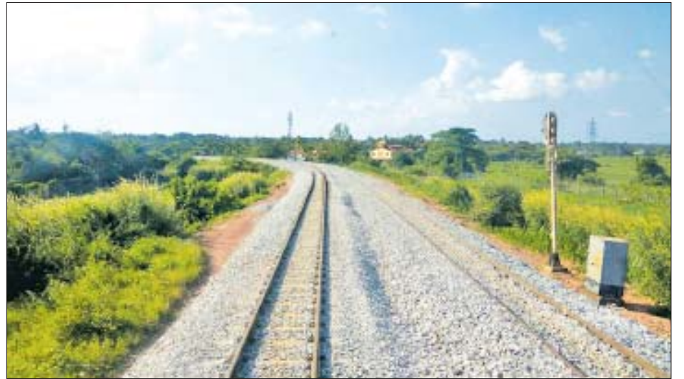
တည်းကုန်း- မင်္ဂလာဒုံ-ပုရွက်ဆိတ်ကုန်း ရထားလမ်းပိုင်းအဆင့်မြှင့်တင်ပြုပြင်ဆောင်ရွက်ထားမှုကို တွေ့ရစဉ်။
