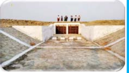
မင်းပြားမြို့နယ်တွင် ကွန်ကရစ်ရေတံခါး (၂)လုံး တည်ဆောက်ခြင်းလုပ်ငန်း ဆောင်ရွက်ပြီးစီးခြင်း
