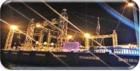
ဆတ်ရိုးကျဓာတ်အားခွဲရုံ တည်ဆောက်ပြီးစီးမှု
