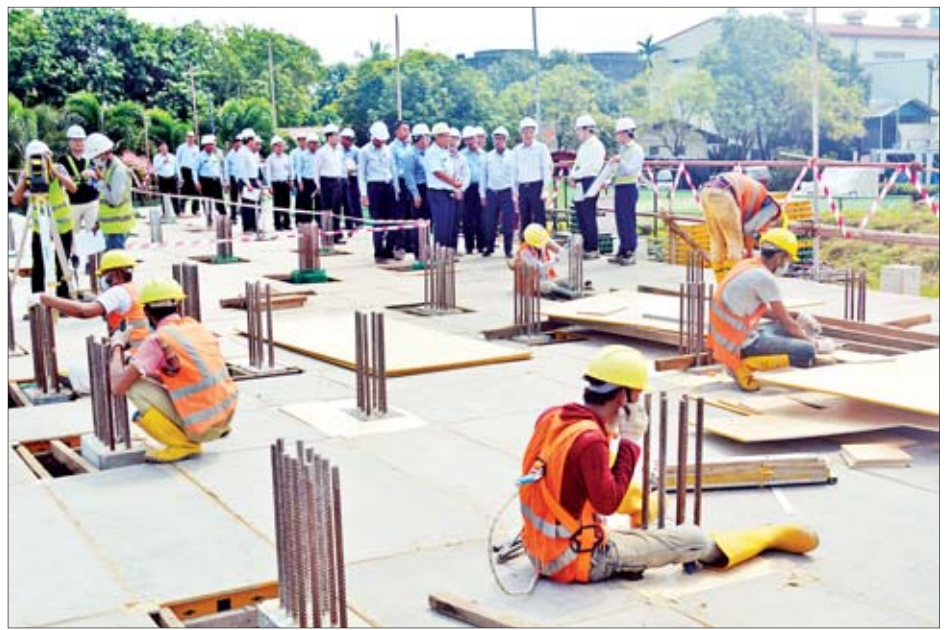
ဌာန (ရန်ကုန်)၌ နိုင်ငံအတွင်း လျှပ်စစ် ပေးနေမှုနှင့် ရုံးအဆောက်အအုံသစ် စစ်ဆေးပြီး လိုအပ်သည်များ မှာကြား ဓာတ်အား ထိန်းချုပ်ပို့လွှတ် ဖြန့်ဖြူး ဆောက်လုပ်နေမှုတို့ကို ကြည့်ရှု ခဲ့ကြောင်း သိရသည်။ သတင်းစဉ်
