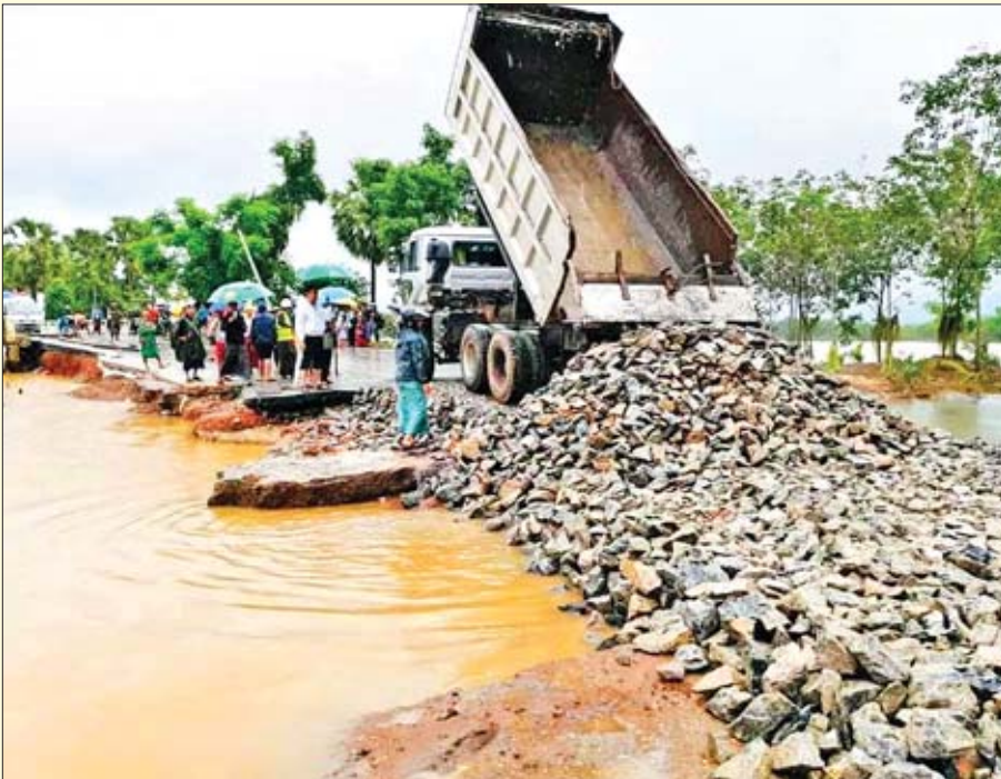
ရန်ကုန်-မော်လမြိုင်-ရေး-မြိတ်လမ်း(သဲဖြူဇရပ်-ရေးအပိုင်း)တွင် မိုးသည်းထန်စွာ ရွာသွန်းမှုကြောင့် လမ်းပျက်စီးမှုများဖြစ်ပေါ်ခဲ့ရာ မော်လမြိုင်ခရိုင် လမ်းဦးစီးဌာန တာဝန်ခံအင်ဂျင်နီယာများနှင့် ဝန်ထမ်းများ ပြင်ဆင်ခြင်းလုပ်ငန်းများ ဆောင်ရွက်နေသည်ကို တွေ့ရစဉ်။
