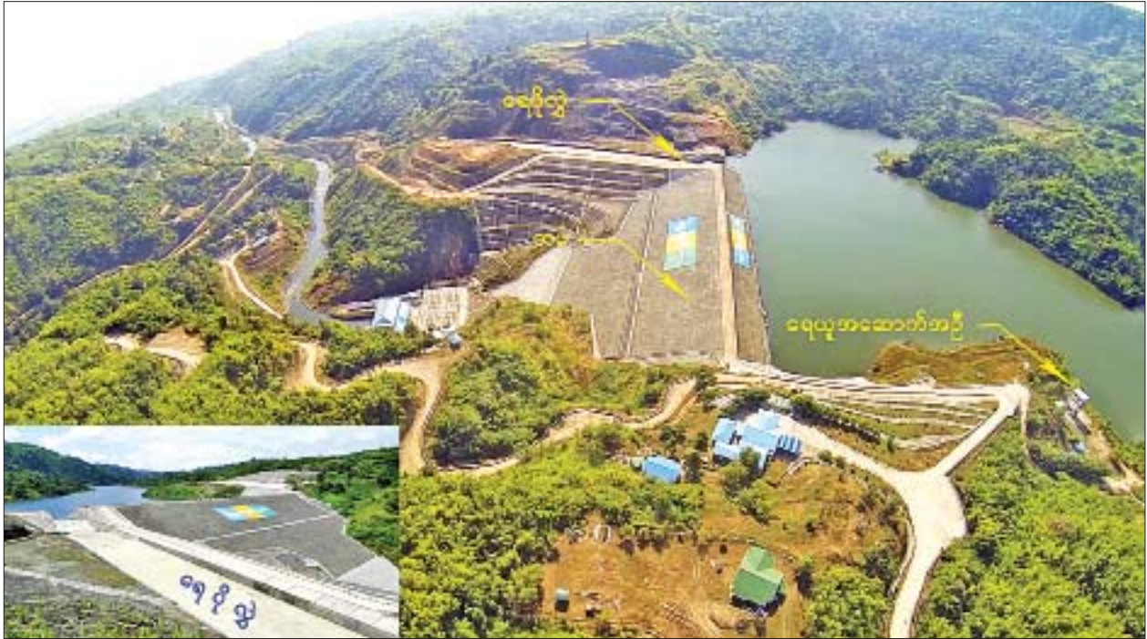
မြူးချောင်းရေလှောင်တံ၊ ရေပိုလွှဲနှင့် ရေလှောင်အဆောက်အအုံကို တွေ့ရစဉ်။
