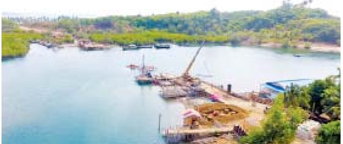
မကျိုးငင်တံတားအသစ် တည်ဆောက်ရေးစီမံကိန်းရှိ ဘိုးပိုင်တူးဖော်ခြင်းလုပ်ငန်းများဆောင်ရွက်နေသည့်ကို တွေ့ရစဉ်။
