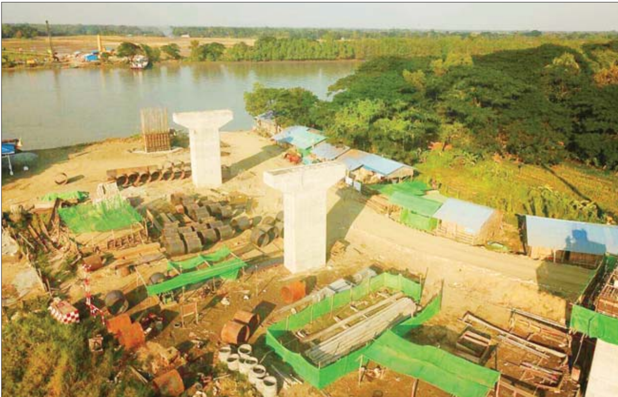
ဘိုကလေး-မော်လမြိုင်ကျွန်း-ကျမဇေး-ဝါးခယ်မ-မြောင်းမြကားလမ်းပေါ်၌ စော်ကဲမြစ်ကူးတံတားတည်ဆောက်နေသည်ကို တွေ့ရစဉ်။
