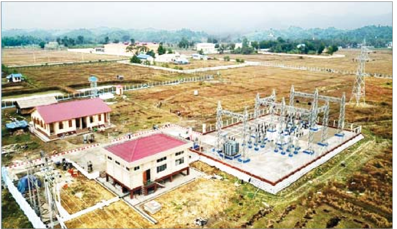
၆၆ ကေဗီ ဘူးသီးတောင်-မောင်တော ဓာတ်အားလိုင်းနှင့် ၆၆/၁၁ ကေဗီ (၅) အမ်ပီအေ မောင်တောဓာတ်အားခွဲရုံကို တွေ့ရစဉ်။
