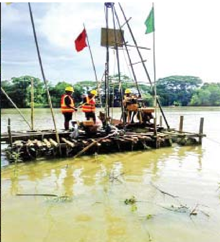
အထွတ်မြစ်ကူး(စံပယ်ဂူ)တံတားဆောက်လုပ်ခြင်းအတွက် မြေစမ်းသပ်ခြင်းလုပ်ငန်း ဆောင်ရွက်နေသည်ကို တွေ့ရစဉ်။
