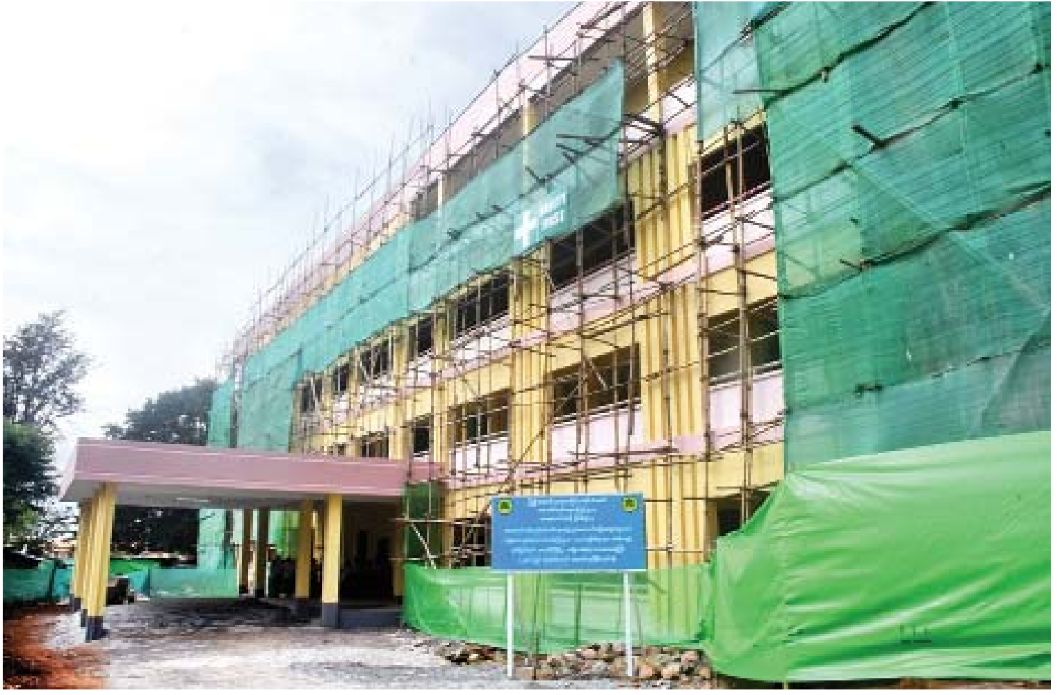
တောင်ကြီးမြို့ အမျိုးသမီးနှင့် ကလေးဆေးရုံကြီး လေးထပ်ဆောင် တည်ဆောက်နေမှုကို တွေ့ရစဉ်။
