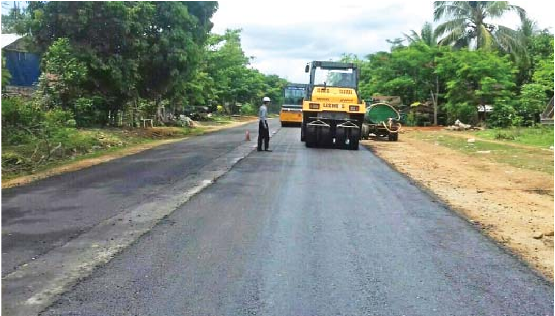
ရန်ကုန်-မြိတ်လမ်းအပိုင်း ကတ္တရာကွန်ကရစ်ခင်းခြင်းလုပ်ငန်း ဆောင်ရွက်နေမှုကို တွေ့ရစဉ်။
