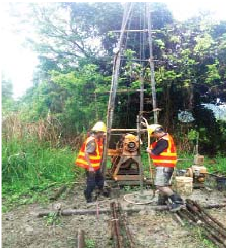
အထွတ်မြစ်ကူး(စံပယ်ဂူ)တံတားဆောက်လုပ်ခြင်းအတွက် မြေစမ်းသပ်ခြင်းလုပ်ငန်း ဆောင်ရွက်နေသည်ကို တွေ့ရစဉ်။
