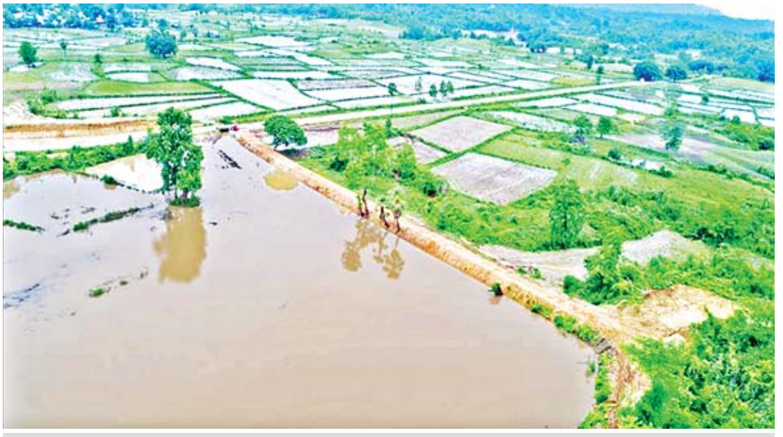
သရက်မြို့နယ် တောမွန်ကျေးရွာအနီးရှိ တောမွန်ကန် ပြန်လည်ပြုပြင်ဆောင်ရွက်ထားမှုကို တွေ့ရစဉ်။
