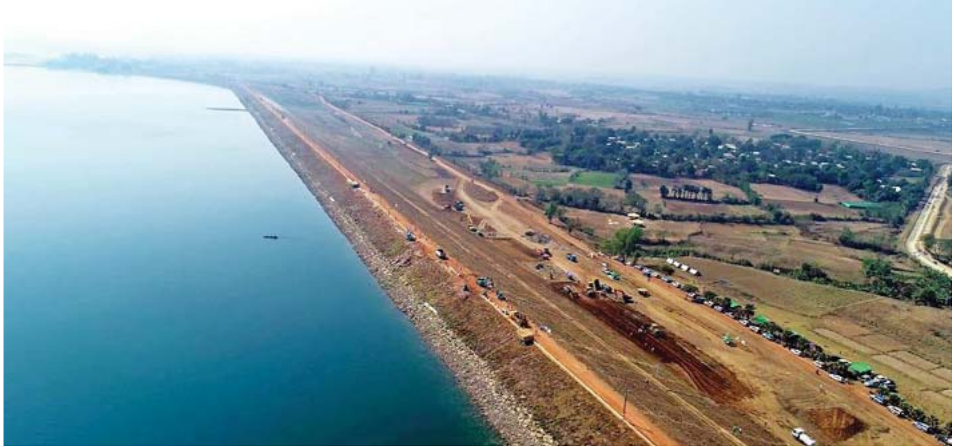
တောင်နဝင်းရေလှောင်တံခံပြုပြင်ဆောင်ရွက်နေမှုကို တွေ့ရစဉ်။
