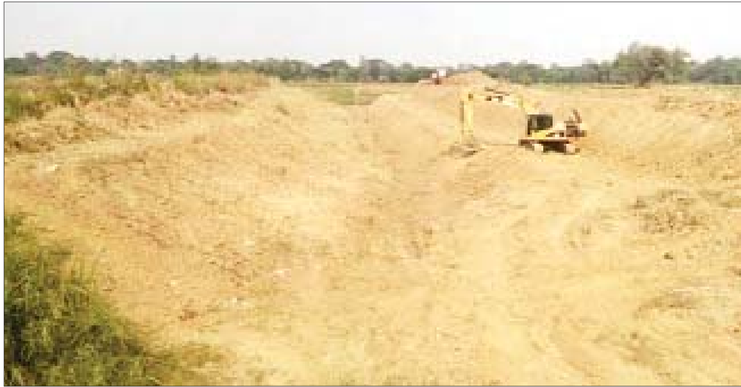
ပဲခူးမြို့ပေါ်ရပ်ကွက်များ ရေကြီးနှစ်မြုပ်မှုမှ လျော့ပါးသက်သာစေရေးအတွက် ခေါင်းဆေးကျွန်းချောင်းအောက်ပိုင်း ရေနုတ်မြောင်းတူးဖော်ဆောင်ရွက်လျက်ရှိသည်ကို တွေ့ရစဉ်။
