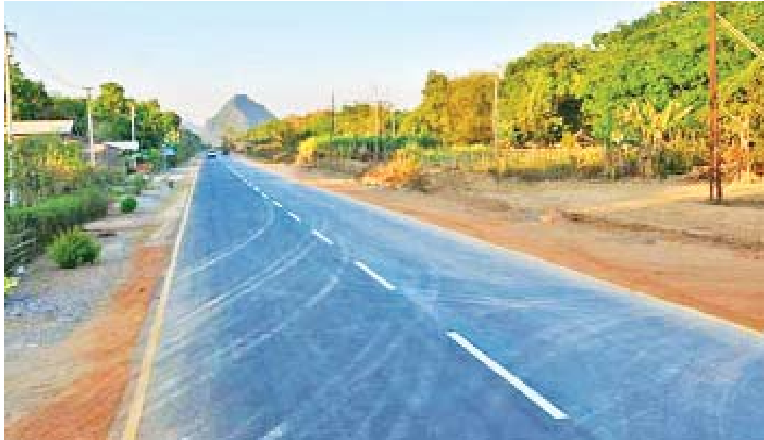
အိန္ဒာ-ဇာသပြင်လမ်းချဲ့ခြင်းနှင့် နိုင်ငံလွန်ကတ္တရာခင်းခြင်းလုပ်ငန်း ဆောင်ရွက်ထားမှုကို တွေ့ရစဉ်။
