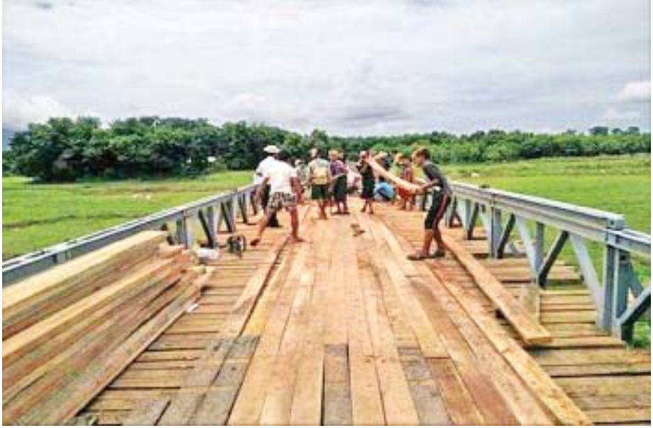
ပိုင်ကျဲချောင်းတံတားကြမ်းခင်းခြင်း၊ ဘီးလမ်းများ လဲလှယ်ပြင်ဆင်ခြင်းလုပ်ငန်း ဆောင်ရွက်နေမှုကို တွေ့ရစဉ်။
