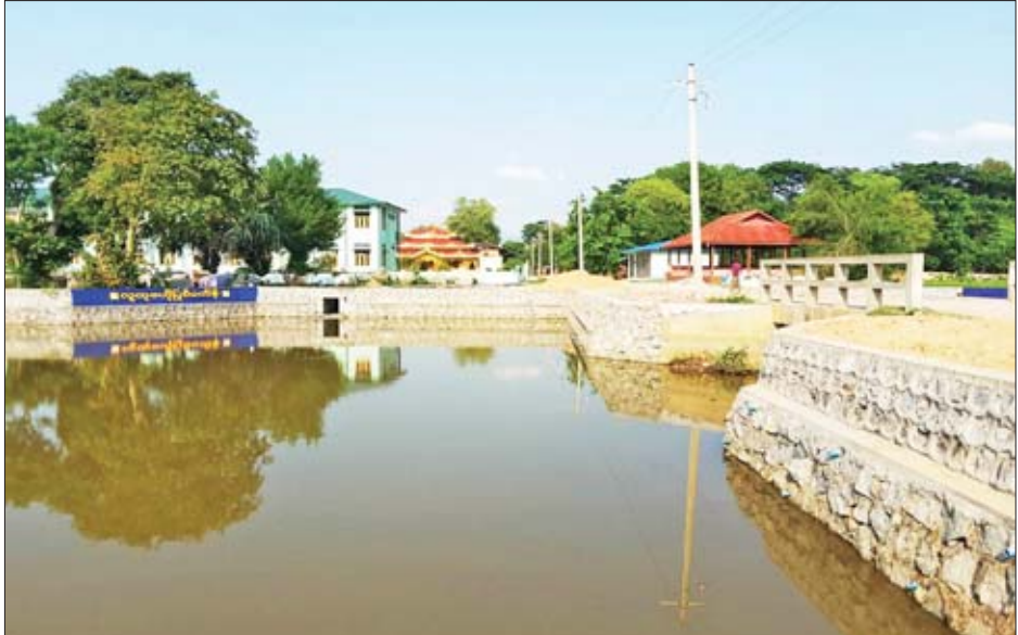
လယ်ဝေးမြို့နယ် အောင်ကုန်းကျေးရွာတွင် မြေထိန်းနံရံ ဆောင်ရွက်ထားရှိမှုကို တွေ့ရစဉ်။
