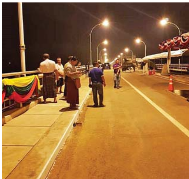
ကြောင်း၊ ထို့အပြင် တံတားသစ်ကြီး ဖွင့်ပွဲပြုလုပ်ရန်နှင့် ဖွင့်လှစ်ပြီးပါက ထိန်းသိမ်း ဆောင်ရွက်မည့် လုပ်ငန်းညှိနှိုင်း အစည်းအဝေးကို ထိုင်းနိုင်ငံဘက်ခြမ်းရှိ အမှတ်(၂) ချစ်ကြည်ရေးတံတား အဝင်၊ အထွက်ဂိတ် အစည်းအဝေးခန်းမ၌ မတ် ၁၅ ရက် နံနက်ပိုင်းတွင် ကျင်းပခဲ့ရာ နှစ်နိုင်ငံတာဝန်ရှိသူများ တက်ရောက် ခဲ့ကြကြောင်း သိရသည်။ သတင်း-ပွင့်သစ္စာ ဓာတ်ပုံ-Tay Zar Aung
