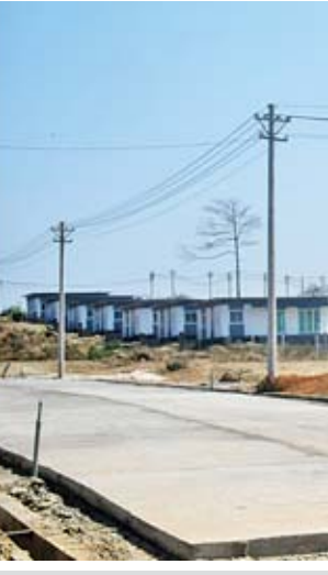
ဒုတိယသမ္မတ ဦးဟင်နရီဇန်ထီးယူ i-Green Project အိမ်ရာ တည်ဆောက်ထားရှိမှုအခြေအနေကို ကြည့်ရှုစစ်ဆေးစဉ်။
