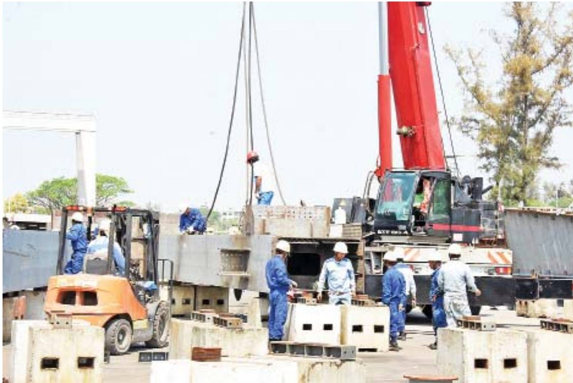
J & M သံမဏိစက်ရုံမှ ဝန်ထမ်းများ လုပ်ငန်းခွင်ဆောင်ရွက်နေမှုကို တွေ့ရစဉ်။
