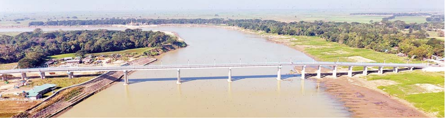
ဧရာဝတီတိုင်းဒေသကြီး ဟင်္သာတခရိုင် လေးမျက်နှာ-ခတ္တုပန်းတောကြီးလမ်းပေါ်ရှိ ငဝန်တံတား (လေးမျက်နှာ) ကို တွေ့ရစဉ်။
