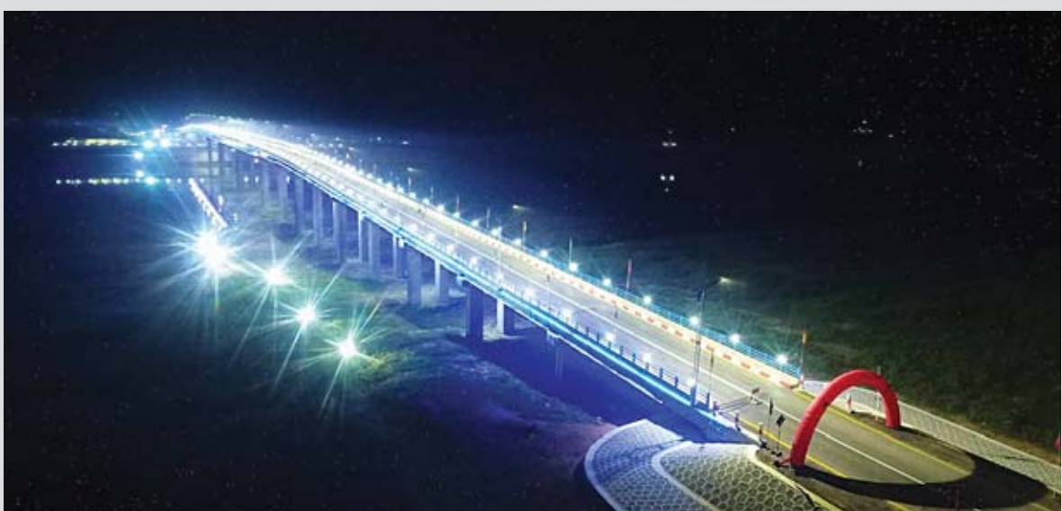
ဇေဇော်ဝါရီ ၃ ရက် (ယနေ့)တွင် ဖွင့်လှစ်မည့် ရော့တီတိုင်းဒေသကြီးရှိ ဝန်တံတား(လေးမျက်နှာ) ညမြင်ကွင်းကို တွေ့ရစဉ်။ (တံတားအရှည်မှာ ၁၉၆၈ ဒဿမ ၆ ပေရှိသည်။ တံတားအကျယ် ၂၄ ပေ၊ တံတားဘေး တစ်ဖက်တစ်ချက်လှည့်လမ်း နှစ်ပေပါရှိပြီး တံတားအမျိုးအစားမှာ အောက်ခံအုတ်မြစ် (1.2)m Bored Pile၊ တံတားကိုယ်ထည် R.C Concrete၊ ရေလမ်းကင်းလွတ်အမြင့်ပေ ၂၀၊ တံတားခံနိုင်ရည်ယာဉ်တစ်စီးချင်း ၇၅ တန်ဖြစ်သည်။) အချက်အလက်-ဉာဏ်လင်းဦး(LMA)၊ ဓာတ်ပုံ-စိုးမြင့်အောင်
