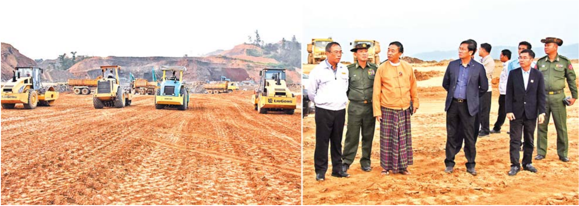
ဒုတိယသမ္မတ ဦးဟင်နရီဗန်ထီးယူ ဖလမ်းမြို့ ဆူရ်ဘုန်လေယာဉ်ကွင်း တည်ဆောက်ရေးစီမံကိန်းလုပ်ငန်းခွင်ကို ကြည့်ရှုစစ်ဆေးစဉ်။
