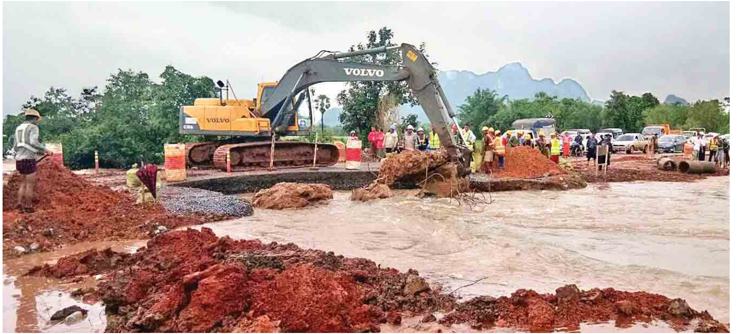
ဘားအံ-မြဝတီ ကားလမ်း တံတားအမှတ်(၁၅)တွင် ရေတိုက်စားမှုကြောင့် ပျက်စီးမှုကို မြင်နေစဉ်။
