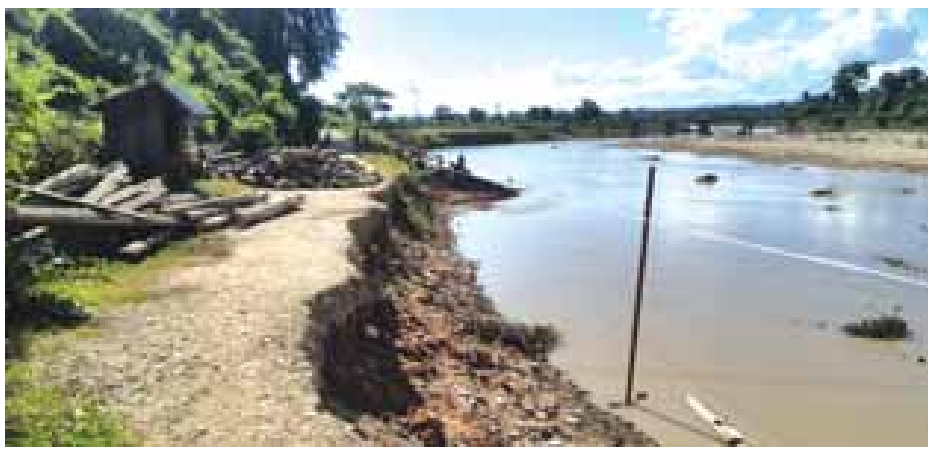
နံရံ တည်ဆောက်ပြုလုပ်မှုကို ရက်ပေါင်း ၆၀ ခန့်နှင့် အပြီးဆောက်လုပ်သွားမည်ဖြစ်ကြောင်း လမ်းဆောင်ရွက်နေသည့်အဖွဲ့မှ တာဝန်ရှိသူ တစ်ဦးက ပြောသည်။ ထို့နောက် ကျေးရွာချင်းဆက်လမ်းသည် မိုးတွင်းကာလရောက်တိုင်း ချောင်းရေတိုက်စားခဲ့သဖြင့် ကျေးရွာလုပ်ဆောင်ရွက်ပေးခဲ့ကြောင်း၊ နေ့စဉ်ဖြတ်သန်းသွားလာနေသူများအသက်အန္တရာယ်စိုးရိမ်ရဖွယ်ရှိနိုင်၍ ချောင်းရေတိုက်စားမှုဒဏ်ကို ကာကွယ်ထိန်းသိမ်းရာလည်းရောက်၊ သွားလာရေးအဆင်ပြေအောင် တည်ဆောက်ဆောင်ရွက်နေကြောင်း သိရသည်။ ခင်မောင်ဆွေ(ဆော်လှ)
