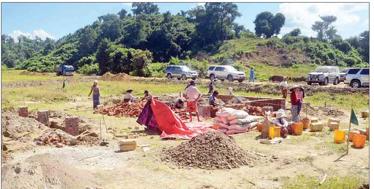
ခုံတိုင်(မြို့)ကျေးရွာသစ် တည်ဆောက်နေမှုကို တွေ့ရစဉ်။
