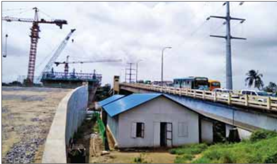
ပုဇွန်တောင်ချောင်းဖြတ် တည်ဆောက်ဆဲ သာကေတတံတားသစ်နှင့် တံတားဟောင်းအား တွေ့ရစဉ်။
