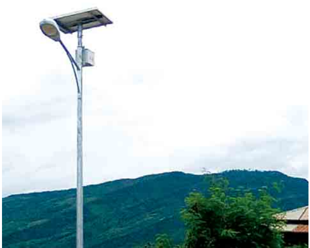
ရန်ပုံငွေထည့်ဝင်မှုစနစ်ဖြင့် ဆောင်ရွက်နေခြင်းဖြစ်ပြီးချင်းပြည်နယ်တွင် ဆောင်ရွက်ပြီးဖြစ်ကြောင်း ကျေးရွာ Zenith Power ကုမ္ပဏီမှ တာဝန်ယူ ဆောင်ရွက်လျက်ရှိရာဇူလိုင် ၂၁ ရက်အထိ ကျေးရွာ ၃၉ ရွာအနက်
