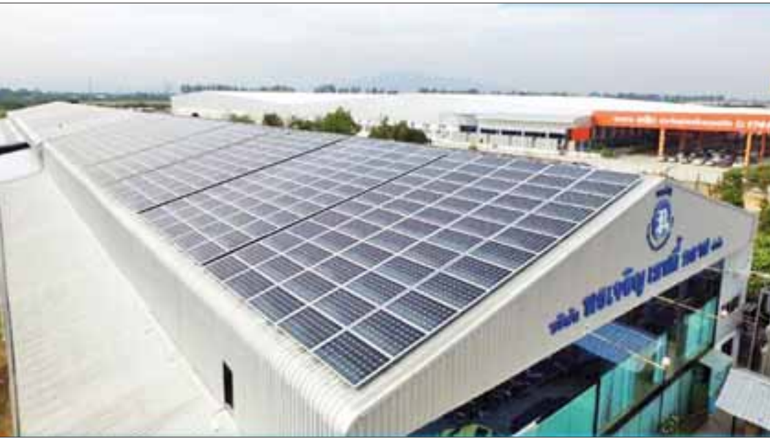
ထိုင်းနိုင်ငံရှိ စက်ရုံ၏ခေါင်မိုးပေါ်၌ ဆိုလာပြားများအား အမိုးသဏ္ဍာန်ပြုလုပ်တပ်ဆင်ပြီး လျှပ်စစ်ဓာတ်အားရယူလျက်ရှိသည်ကို တွေ့ရစဉ်။
