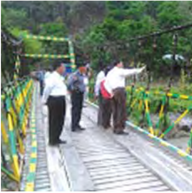
ကူးပေးသည့် ကြိုးတံတားဖြစ် ယာဉ် ၅ တန်း၊ ကုန် ၅ တန်းဖြစ် ကြောင်း၊ တံတားသည် အလျား ပေ ကြောင်း သိရသည်။ ၂၀၀၊ အနံ ၁၀ ပေ ဖြစ်ပြီး ခံနိုင်ဝန်မှာ မြို့ပြန်/ဆက်
