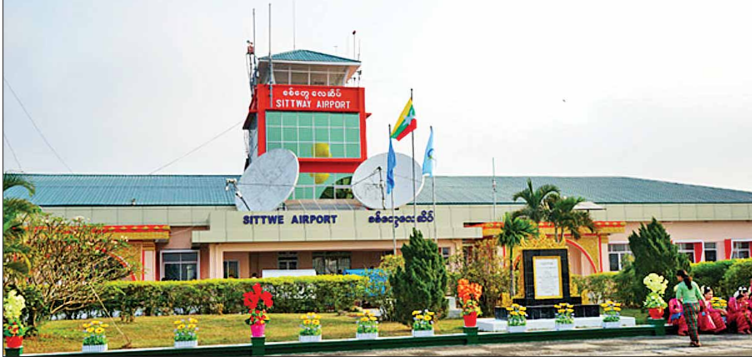
စစ်တွေလေဆိပ်အဆောက်အအုံသစ်ကို ၂၀၁၆-၂၀၁၇ ဘဏ္ဍာနှစ်အတွင်း အပြီးတည်ဆောက်ပေးနိုင်ခဲ့သလို အရေးကြီးပုဂ္ဂိုလ်နားနေဆောင်သစ် အဆောက်အအုံကိုလည်း တည်ဆောက်ပေးနိုင်ခဲ့ပါသည်။
