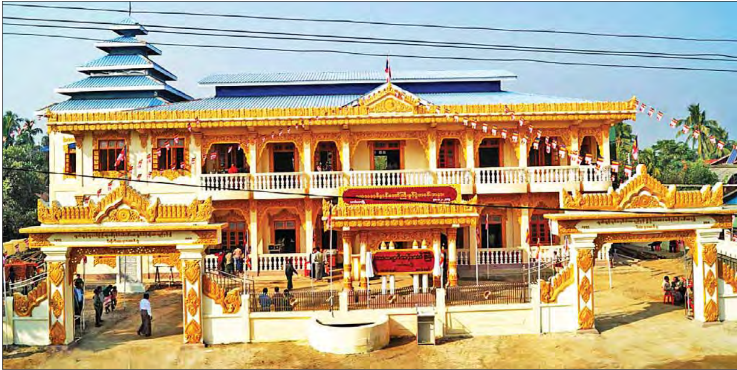
ရခိုင်ပြည်နယ် မောင်တောမြို့နယ်၌ သာသနာ့ဗိမာန်တော်ကြီး တည်ဆောက်ပြီးစီးမှုကို တွေ့ရစဉ်။
