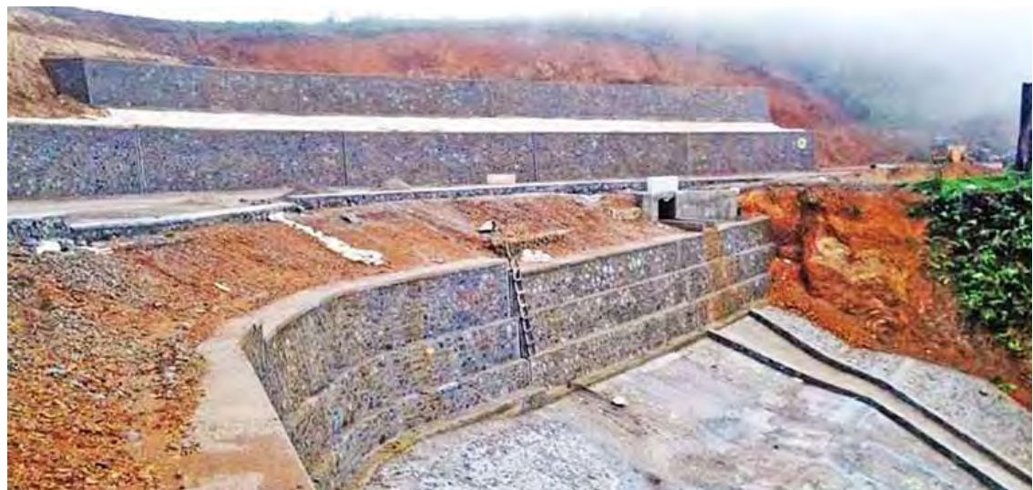
မင်းဘူး-အမ်း-စစ်တွေလမ်း ကျောက်စီမြေထိန်းနံရံတည်ဆောက်ထားရှိမှုကို တွေ့ရစဉ်။
