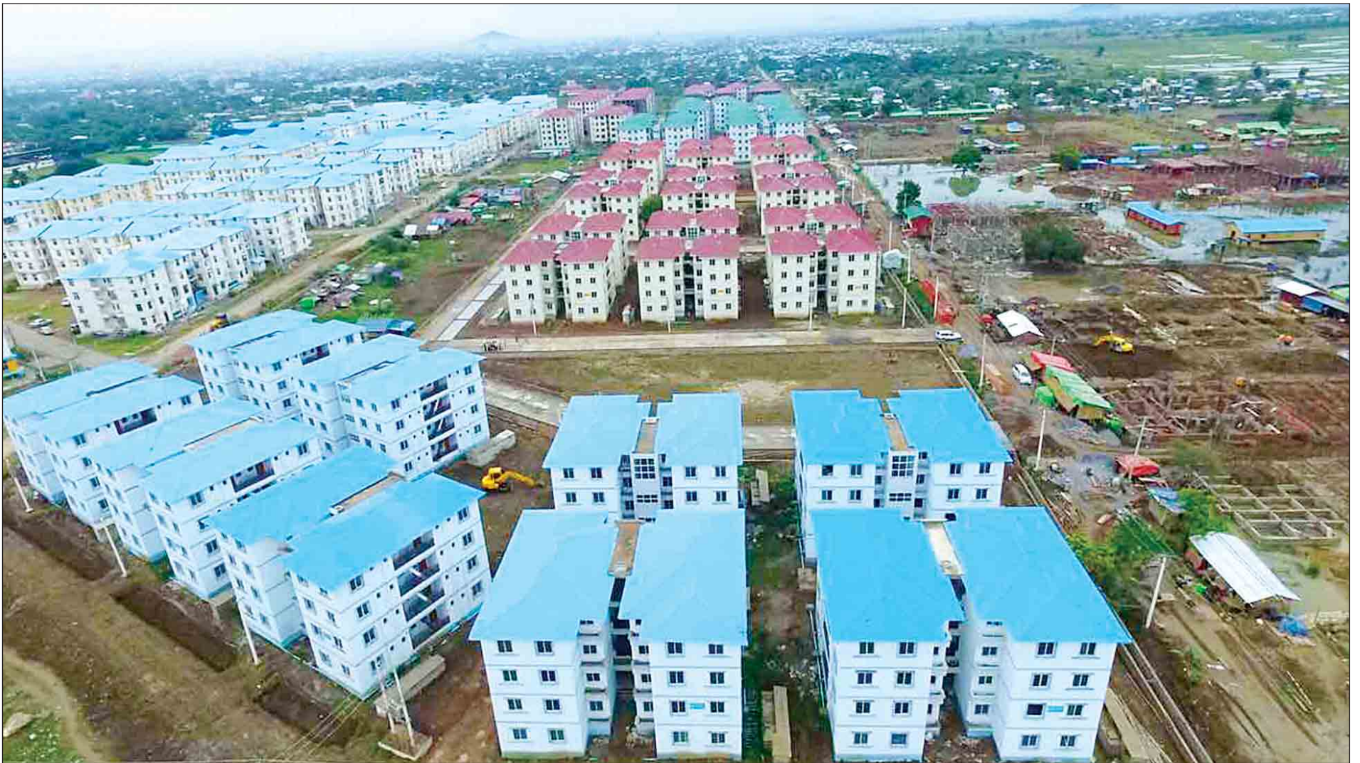
မန္တလေးမြို့၌ တည်ဆောက်ပြီးစီးသွားသည့် မြရည်နန္ဒာအိမ်ရာကို တွေ့ရစဉ်။ (ဓာတ်ပုံ-ဆောက်လုပ်ရေး)
