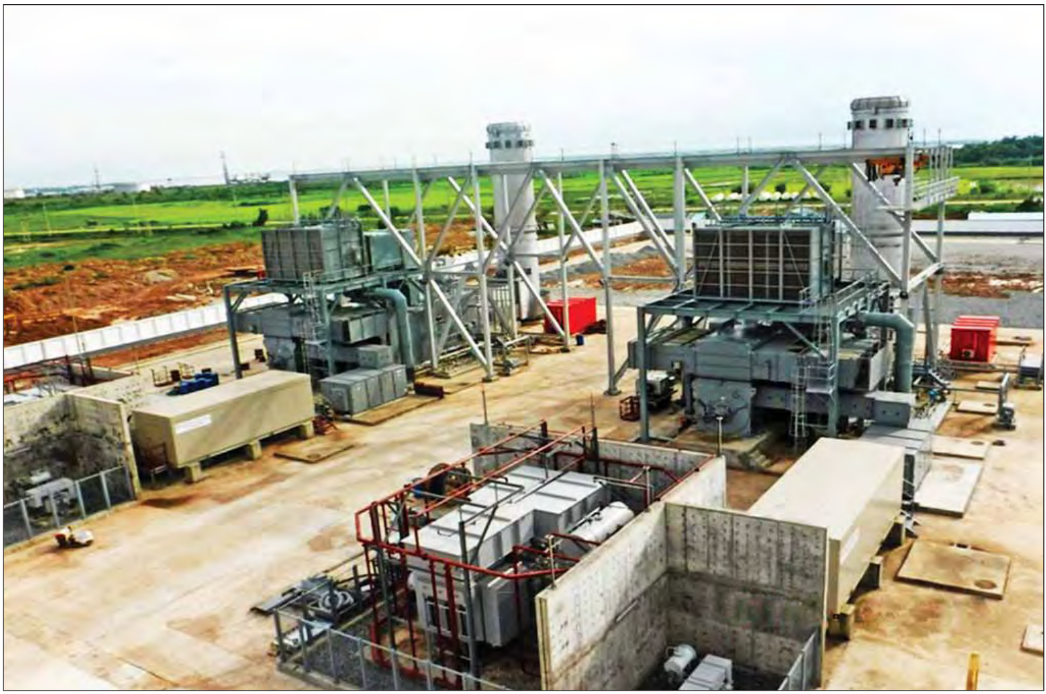
ရန်ကုန်တိုင်းဒေသကြီးအတွင်းရှိ သီလဝါ ၅၀ မဂ္ဂါဝပ် သဘာဝဓာတ်ငွေ့သုံးဓာတ်အားပေးစက်ရုံ တည်ဆောက်ပြီးစီးမှုကို တွေ့ရစဉ်။
