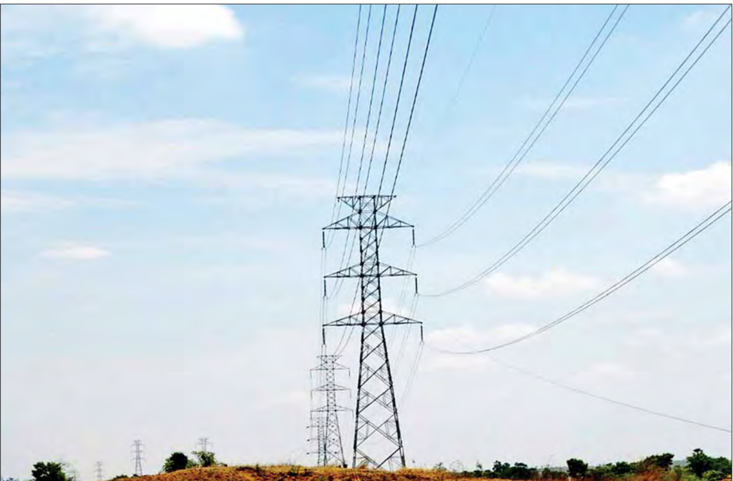
၂၃၀ ကေဗီ တောင်တွင်းကြီး-ရွှေတောင် ဓာတ်အားလိုင်းကို တွေ့ရစဉ်။
